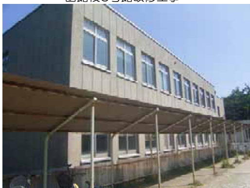
函館校6号館南面外部（改修前）
