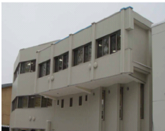
旭川校音楽棟外観（改修後）
