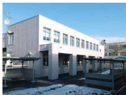
函館校6号館南面外部（改修後）
