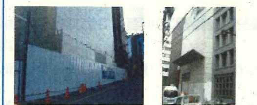
防音パネルの施工例① 防音パネルの施工例②
